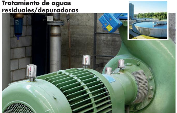
El lubricador de 60 ml en el motor eléctrico y en el eje de transmisión asegura la lubricación continua de una bomba centrífuga.
