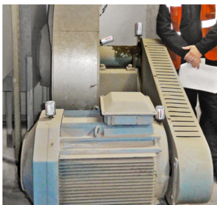
Un ventilatore di combustione lubrificato con due simalube 60 ml e due simalube 125 ml.
