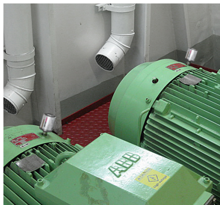
I motori elettrici ABB sono equipaggiati con lubrificatori 60 ml simalube.
