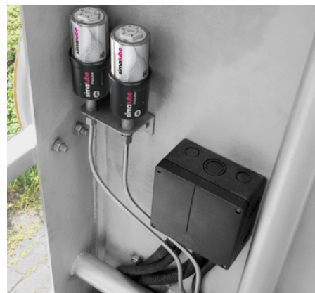
Due simalube IMPULSE connect superano la contropressione di due cuscinetti su un impianto di depurazione assicurando una lubrificazione continua.
