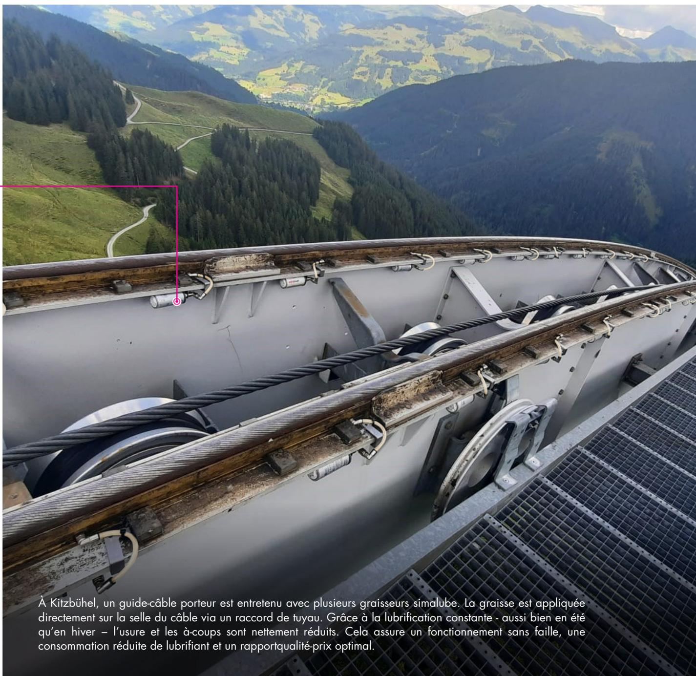
À Kitzbühel, un guide-câble porteur est entretenu avec plusieurs graisseurs simalube. La graisse est appliquée directement sur la selle du câble via un raccord de tuyau. Grâce à la lubrification constante - aussi bien en été qu'en hiver - l'usure et les à-coups sont nettement réduits. Cela assure un fonctionnement sans faille, une consommation réduite de lubrifiant et un rapport qualité-prix optimal.
