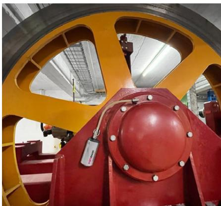
Les poulies de renvoi peuvent être lubrifiées automatiquement, facilement et de manière fiable avec un simalube de 125 ml via une conduite flexible.
