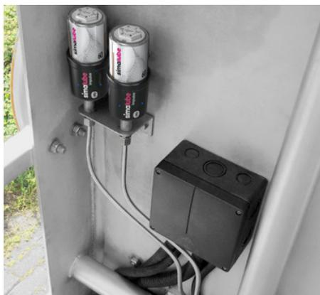
Deux simalube IMPULSE connect sont installés sur des conduites rigides d'un raclor de bassin de décantation. Ils surmontent la contre-pression et assurent une lubrification continue.
