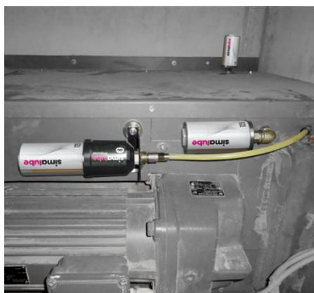
La graisse est amenée au point de graissage par le biais d'une longue conduite. Un support de montage muni de deux aimants, fixe le simalube IMPULSE connect à l'installation.
