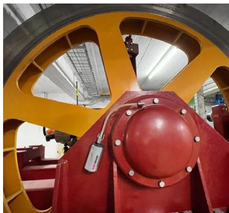
Las poleas pueden lubricarse de forma automática, sencilla y fiable con un simalube de 125 ml a través de una manguera.
