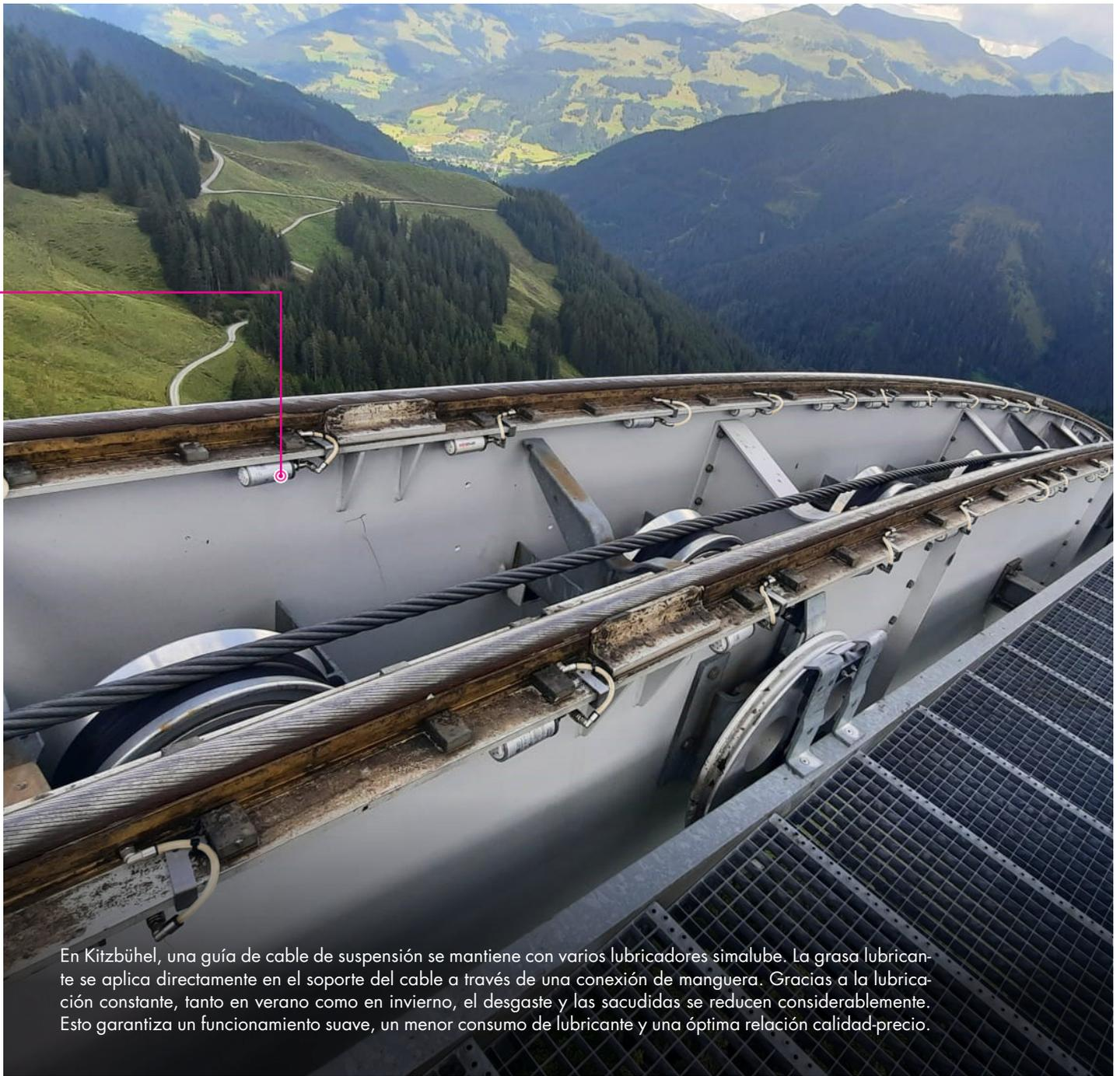
En Kitzbühel, una guía de cable de suspensión se mantiene con varios lubricadores simalube. La grasa lubricante se aplica directamente en el soporte del cable a través de una conexión de manguera. Gracias a la lubricación constante, tanto en verano como en invierno, el desgaste y las sacudidas se reducen considerablemente. Esto garantiza un funcionamiento suave, un menor consumo de lubricante y una óptima relación calidad-precio.
