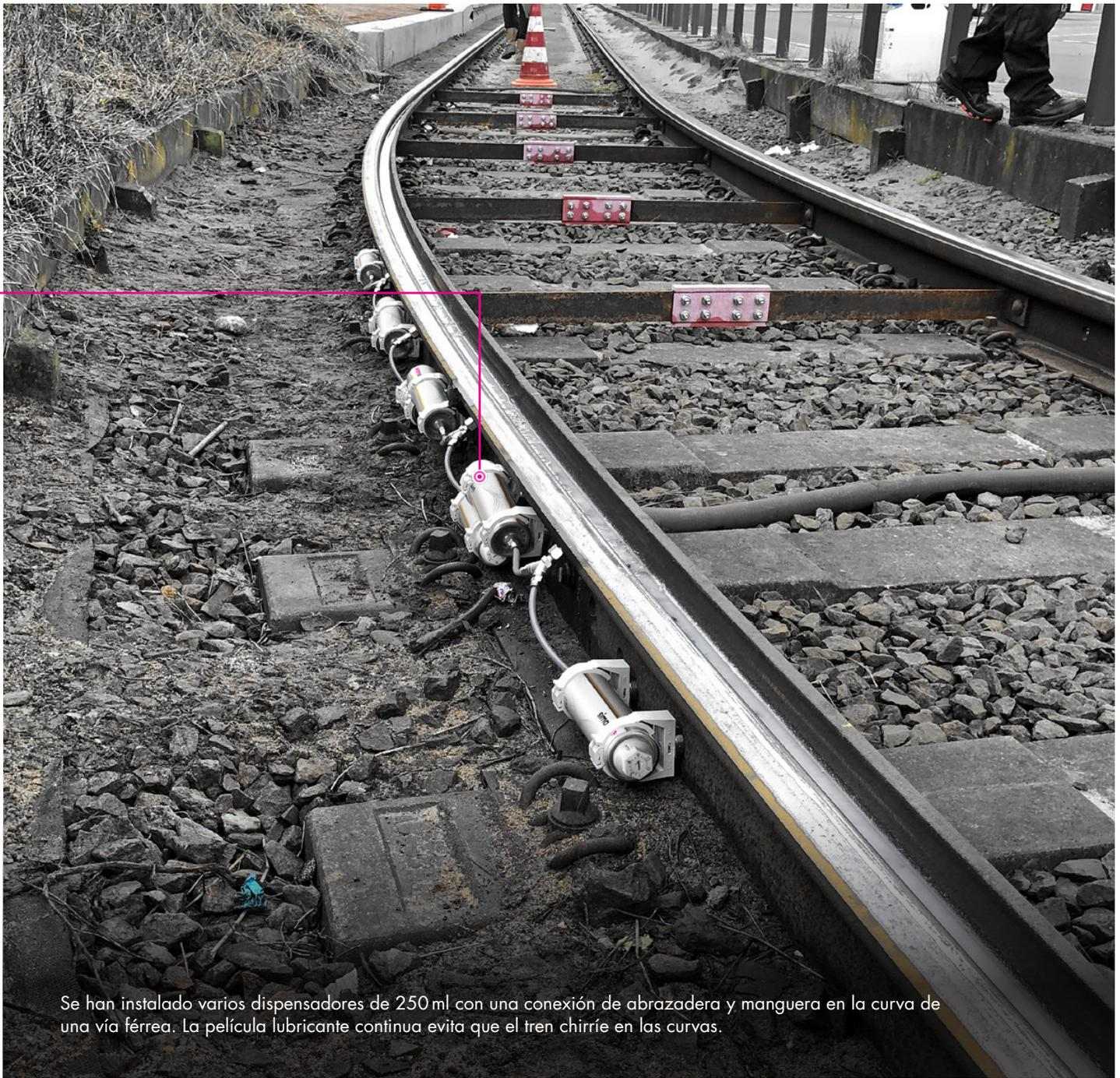
Se han instalado varios dispensadores de 250 ml con una conexión de abrazadera y manguera en la curva de una vía férrea. La película lubricante continua evita que el tren chirríe en las curvas.
