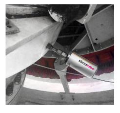
En esta instalación eólica, el lubricador simalube se ha ajustado a un tiempo de dosificación de seis meses.
